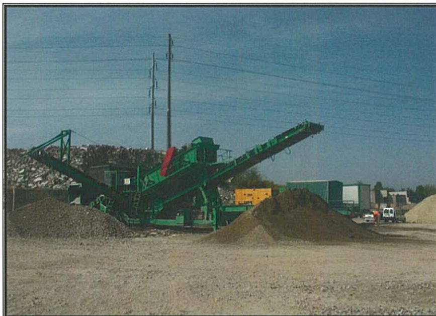
Installation mobile de recyclage de produits de démolition (photo prise sur un autre site).
